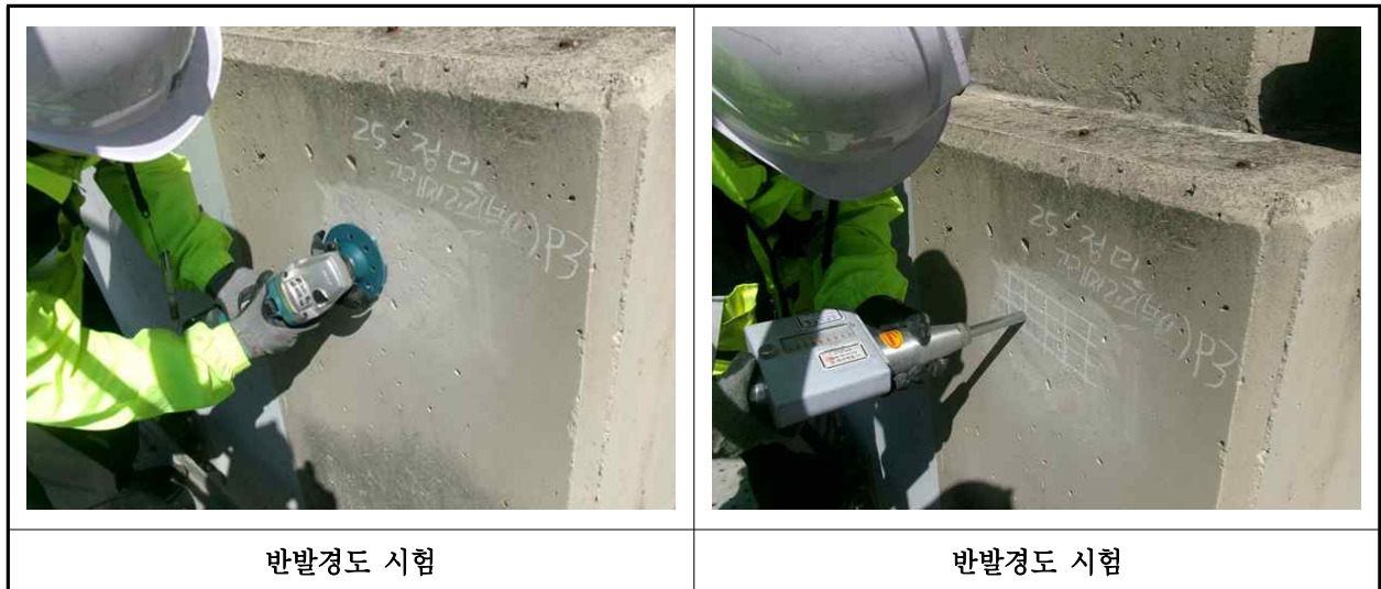
【사진 5.4.2】 반발경도시험 현장사진
