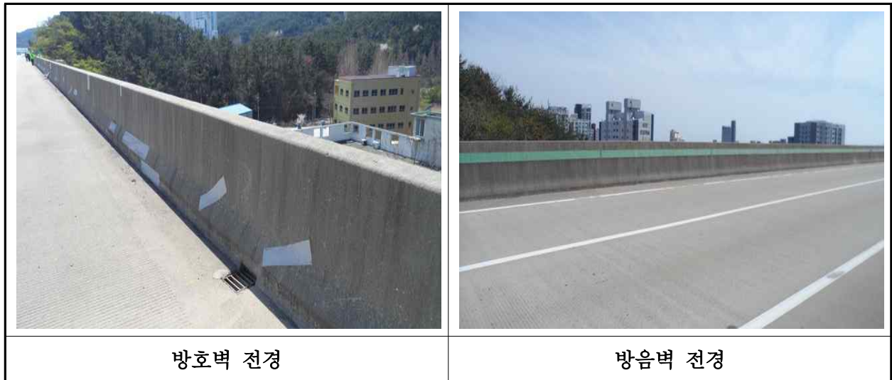
【사진 5.3.24】 방호벽 및 중분대 전경
