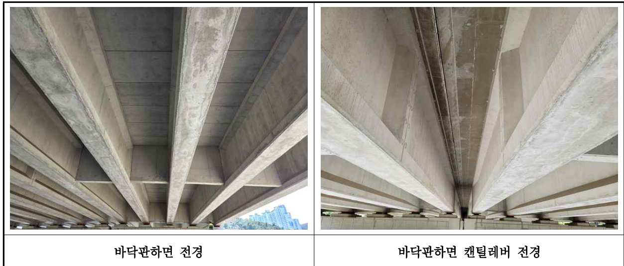
【사진 5.3.2】 바닥판하면 전경
