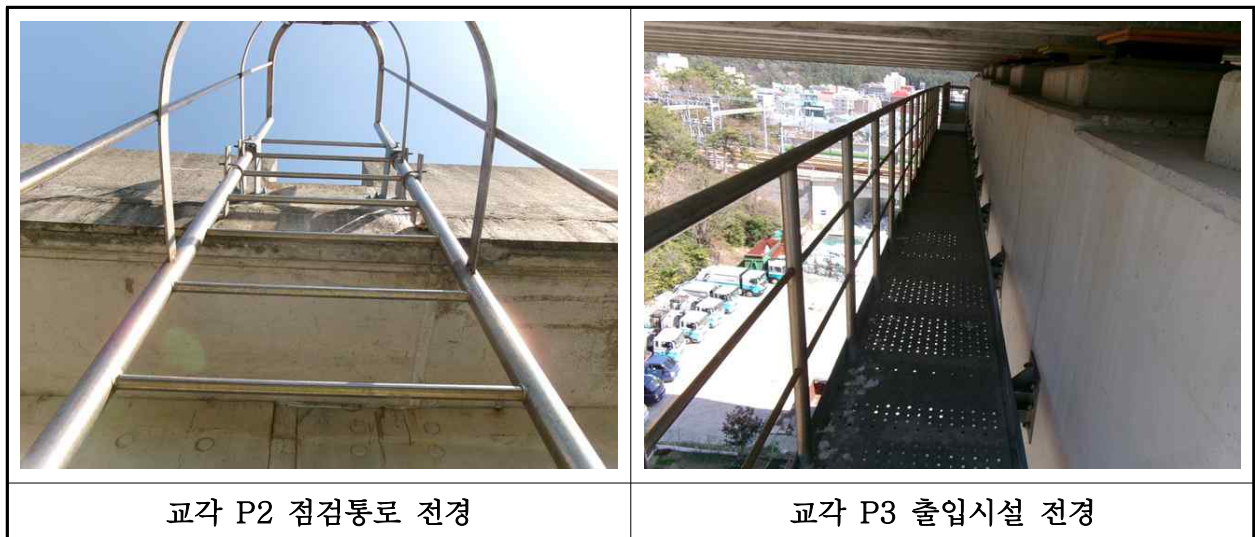
【사진 5.3.26】 교량 점검시설 전경
