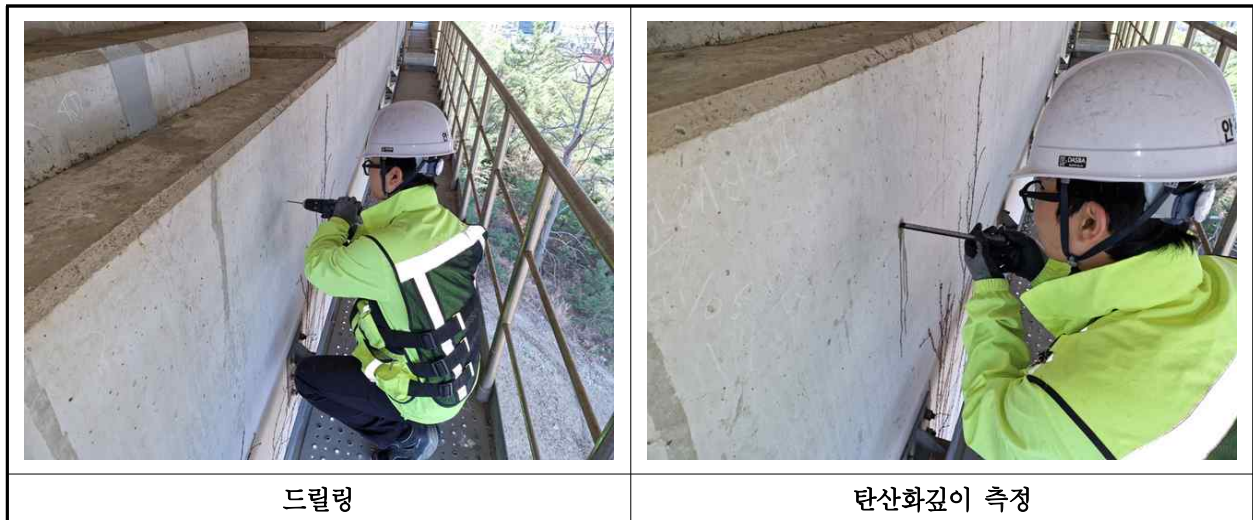
【사진 5.4.3】 탄산화 깊이 측정 현장사진
