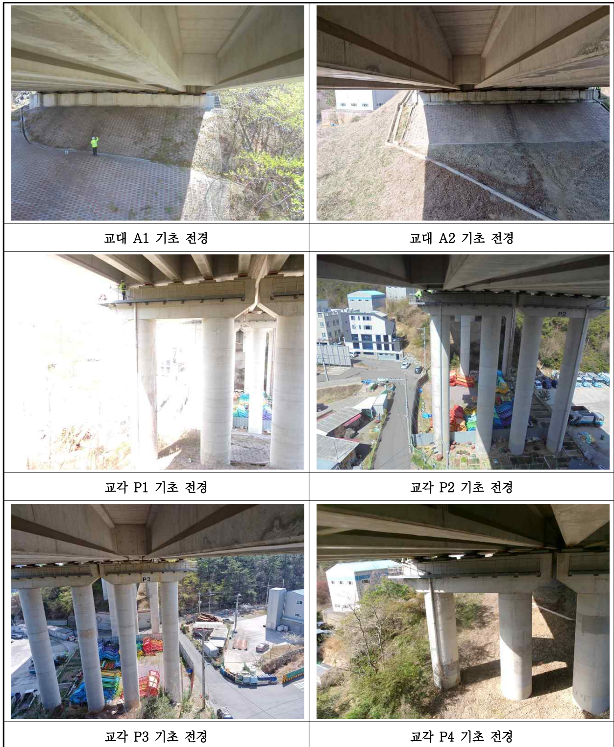
【사진 5.3.12】 기초 전경
