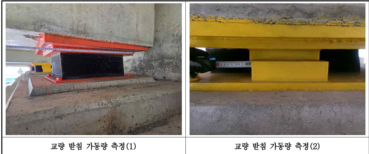
【사진 5.3.16】 교량받침 이동량 측정
