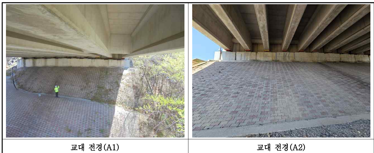
【사진 5.3.8】 교대 전경
