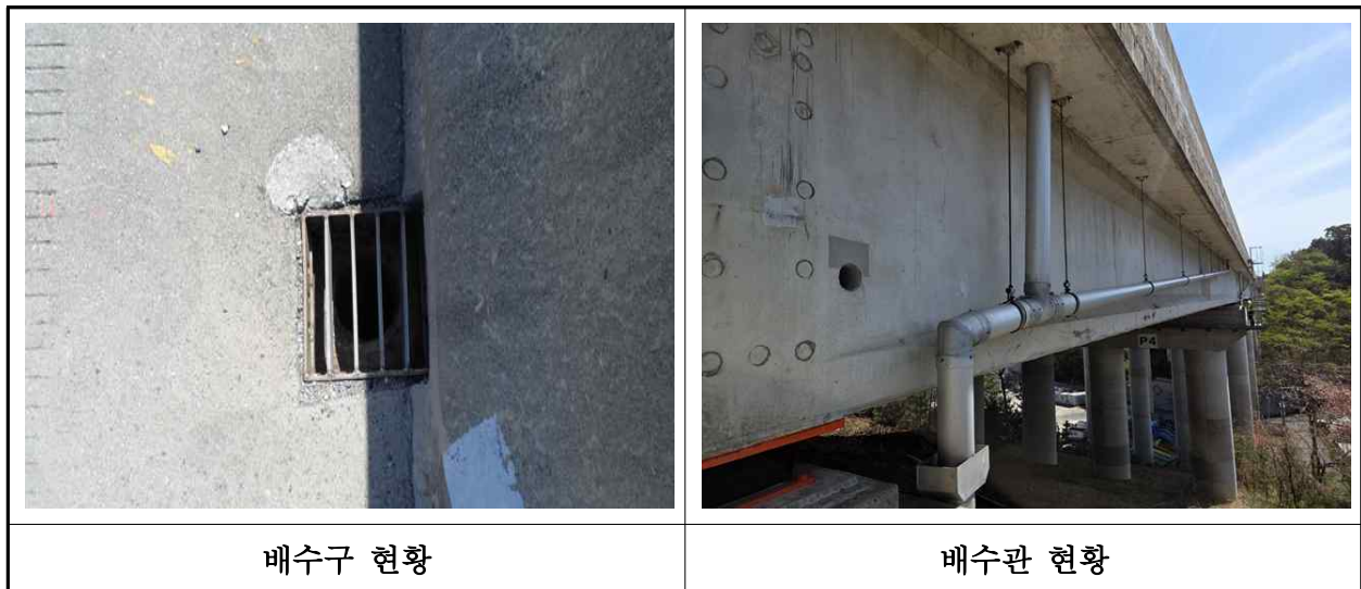
【사진 5.3.22】 배수시설 전경
