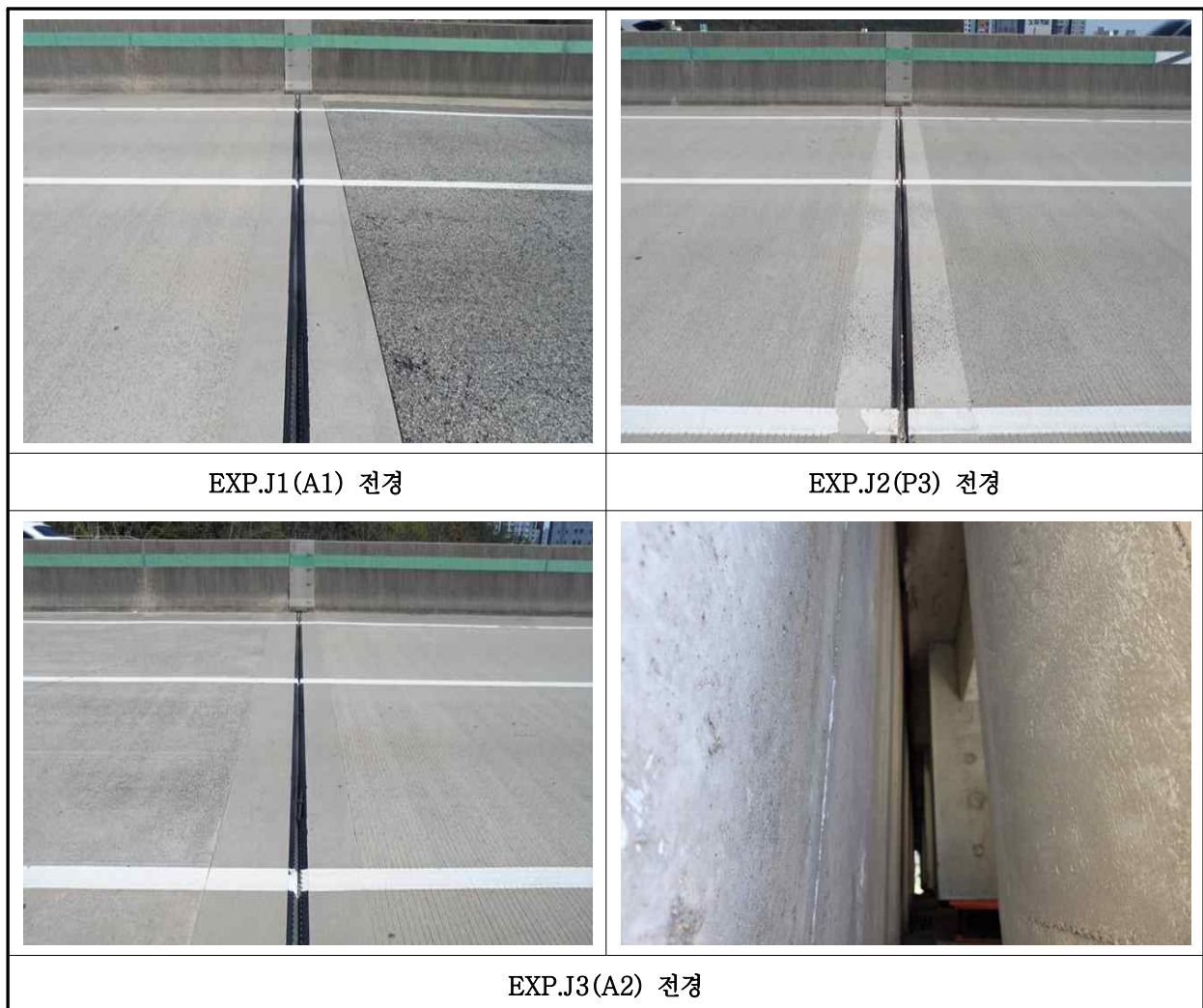
【사진 5.3.17】 신축이음장치 전경
