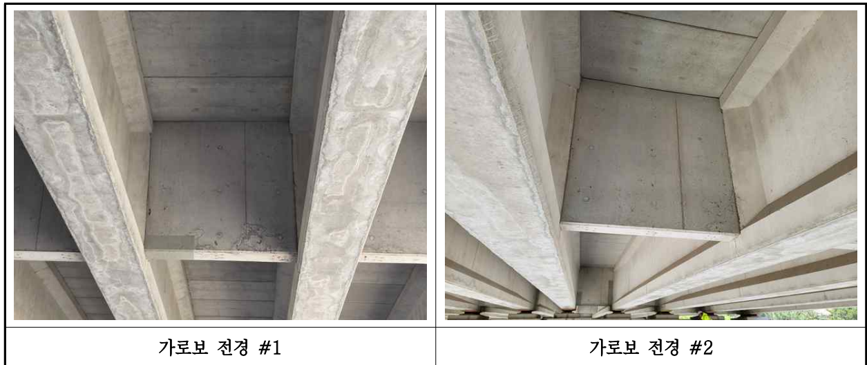
【사진 5.3.6】 가로보 전경
