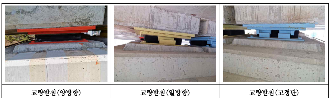
【사진 5.3.13】 교량받침 전경
