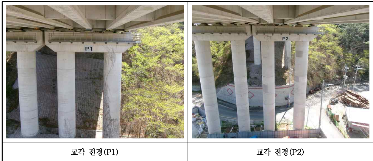
【사진 5.3.10】 교각 전경
