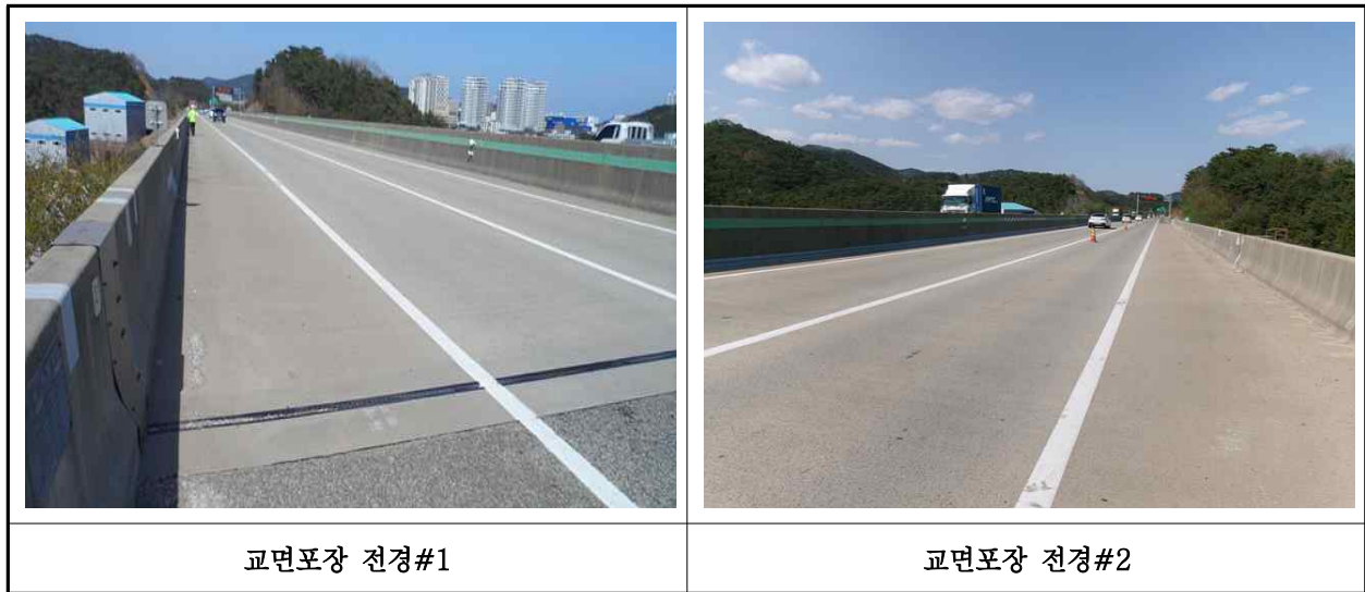
【사진 5.3.20】 교면포장 전경
