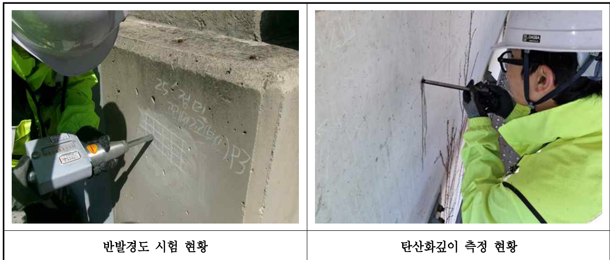
【사진 5.4.1】 콘크리트 내구성조사 현황
