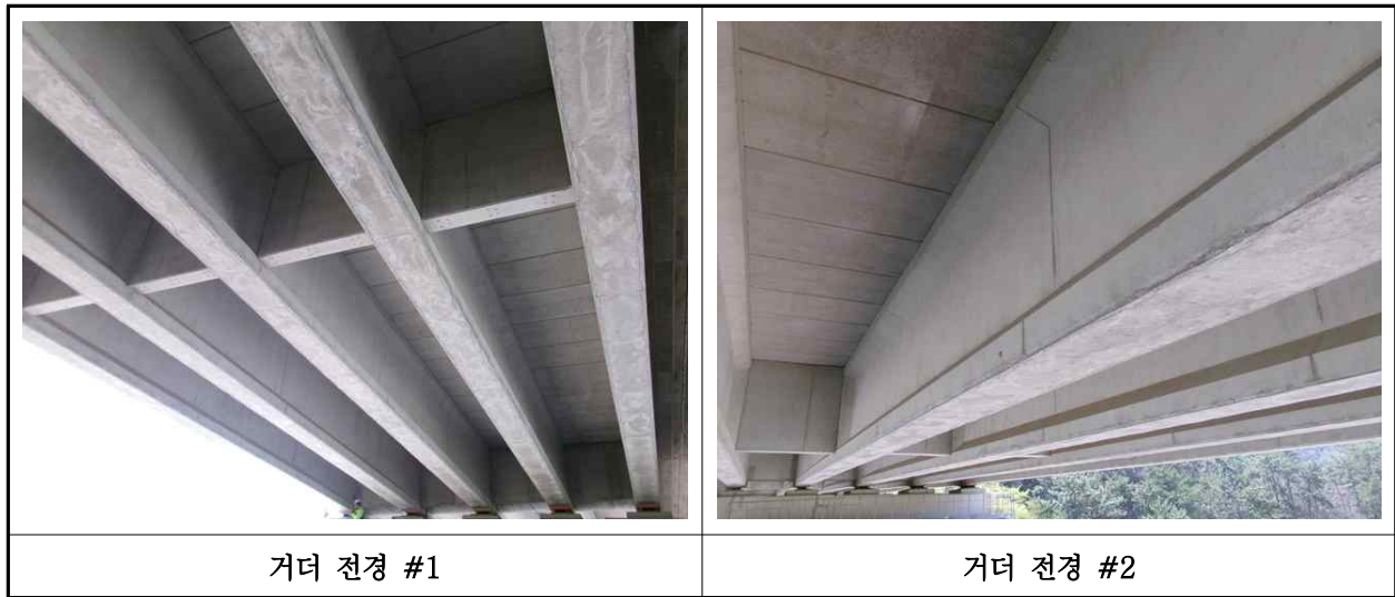
【사진 5.3.4】 거더 전경
